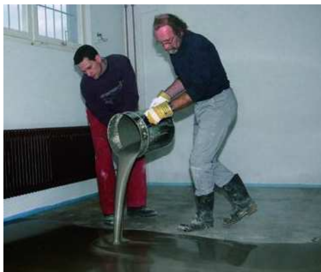
Эффективное выравнивание полов с помощью PCI Periplan перед укладкой верхних покрытий.
