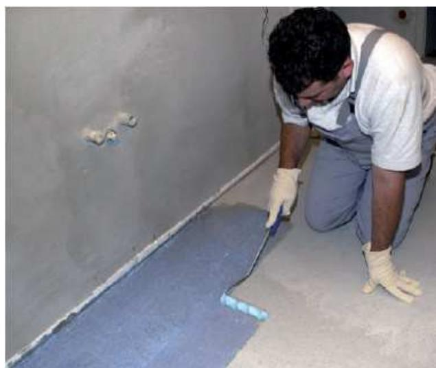
PCI Gisogrund защищает выравнивающую смесь и тонкослойный раствор от слишком быстрой дегидратации, увеличивает время схватывания, улучшает сцепление и предотвращает образование трещин, вызванных усадкой.
