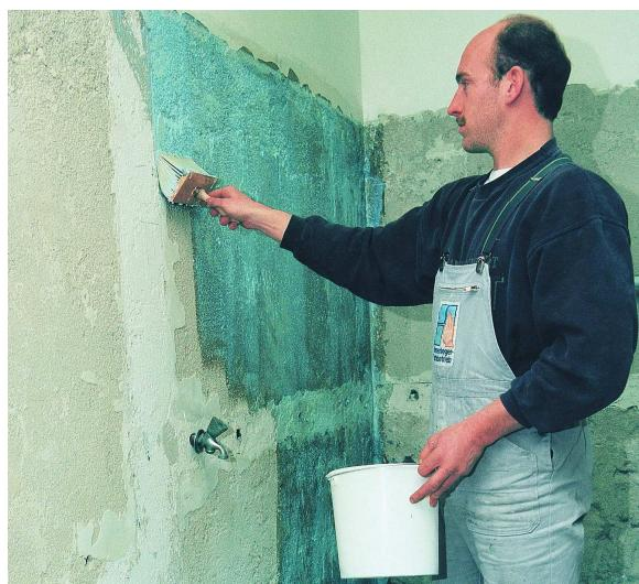
PCI Gisogrund повышает прочность и твердость старой рыхлой штукатурки и увеличивает сцепление с плиткой, гипсокартоном и обоями.
