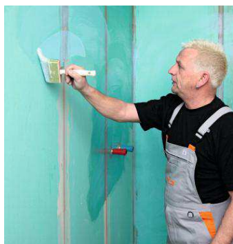
1. Грунтование поверхности: впитывающие основания на гипсовой основе и из гипсокартона следует грунтовать PCI® Gisogrund.
