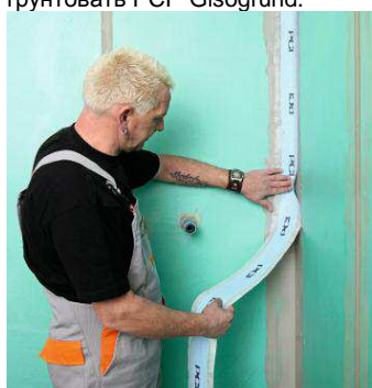
2. Наложите PCI® Pesticare Objekt на PCI® Lastogum (серый) в угловых стыках и примыканиях пол/стена.
