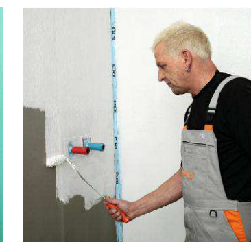
5. После высыхания примерно через час нанесите второе защитное покрытие PCI® Lastogum (белый). Первое покрытие PCI® Lastogum (серый) не должно просвечивать, иначе может потребоваться еще один слой.
