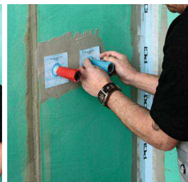
4. Наклейте PCI® Pesticare 10x10 на трубные соединения, выступающие из стены, и покройте PCI® Lastogum (серый).
