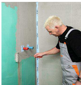
3. Нанесите первый слой PCI® Lastogum (серый) на прогрунтованную поверхность с заходом на ленту
