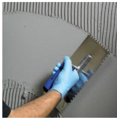
Нанесите второй слой гидроизоляции при помощи шпателя
