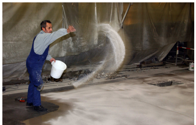
Посыпка песком грунтовки PCI Eroxigrund 390
