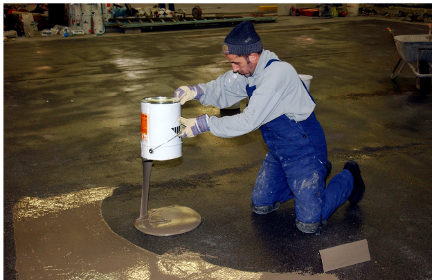
Применение гидроизоляции PCI Apoflex F
