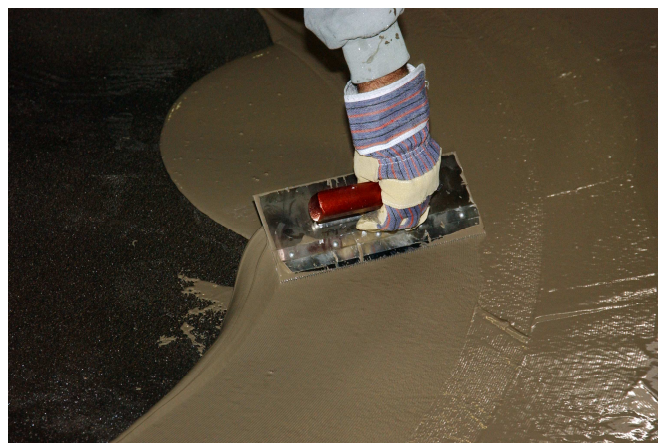
Укладка PCI Apoflex на прогрунтованное основание
